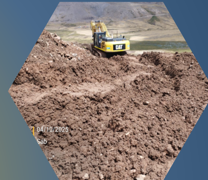
CONSTRUCCION DE LOS CAMINOS DE ACCESO DE LA L. T. 66KV ARCATA - CRESPO - (TRAMO T87 AL T117) TRAMO 2B
