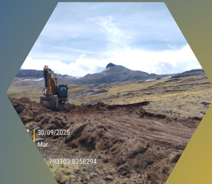
APERTURA DE CARRETERAS EN CHOCÑIHUAQUI - UM CRESPO.
