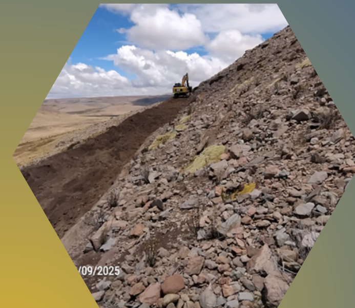
CONSTRUCCION DE LOS CAMINOS DE ACCESO DE LA L. T. 66KV ARCATA - CRESPO - TRAMO 1"
